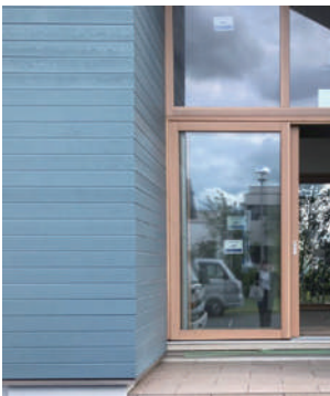
外壁パネル塗りつぶし塗装施工例
