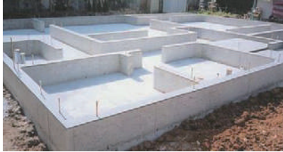
不同沈下に強い鉄筋コンクリートベタ基礎を採用しています。
